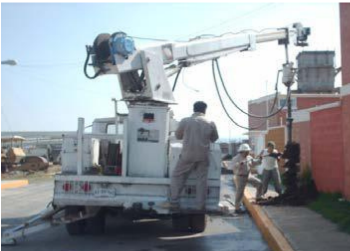
Apertura de Cepa para Poste de Concreto - Red de M.T.
