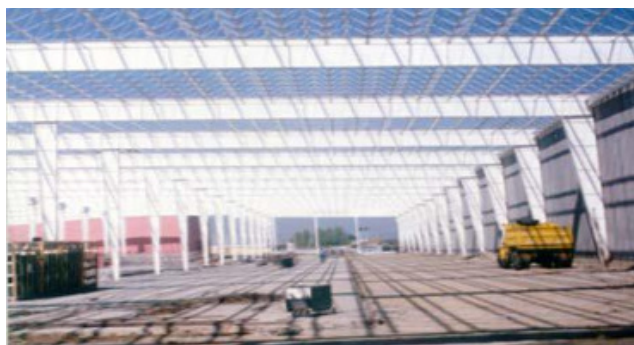
ESTRUCTURA PISO VENTAS
