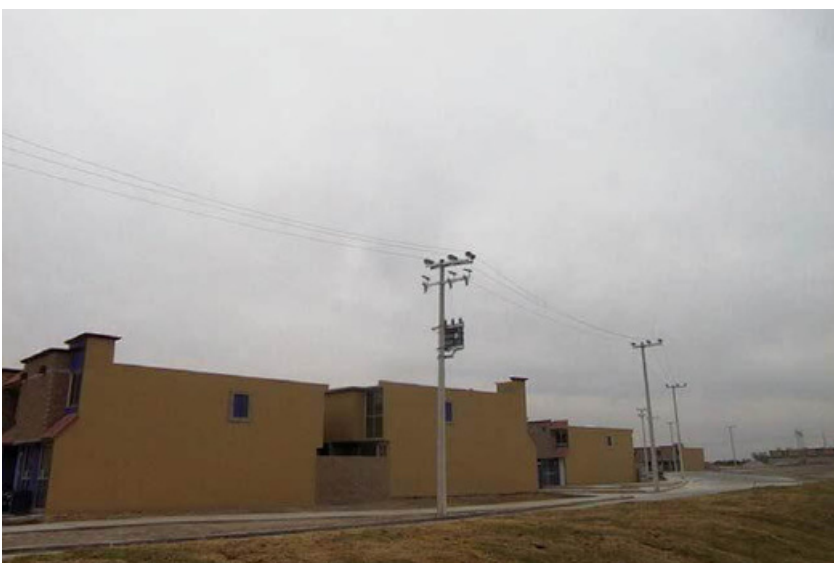
Red de Media Tensión en 23 kV - Red de Baja Tensión 220/120 Vca
