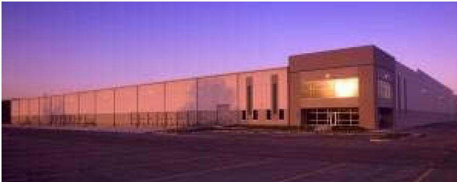
EDIFICIO 10 PROLOGIS TEPOZOTLAN ANTES CEDROS BUSSINES PARK
