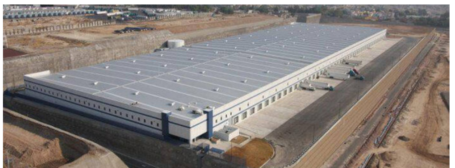
Centro de Distribución Michelin - Patio de Maniobras
