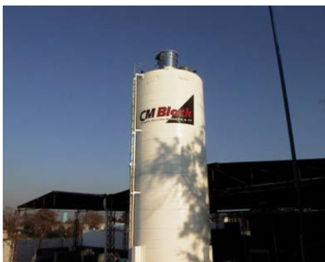
Silo para Cemento
