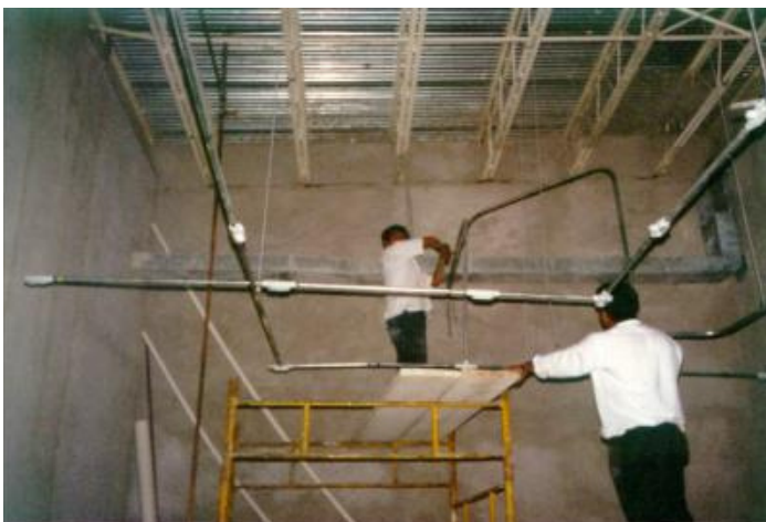
INSTALACIÓN DE CANALIZACIÓN P/CIRCUITOS ALUMBRADO
