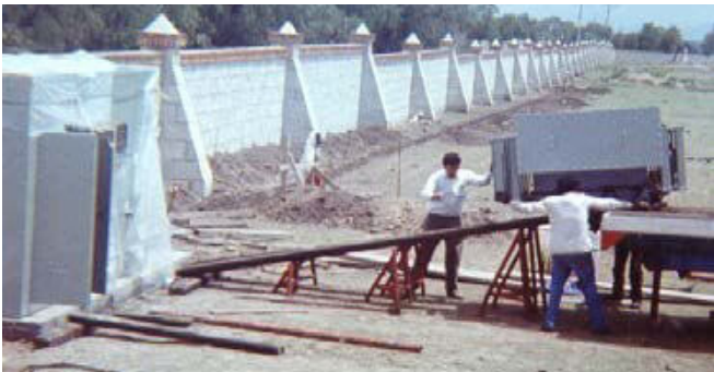
BASE Y MANOBRAS DE MONTAJE
