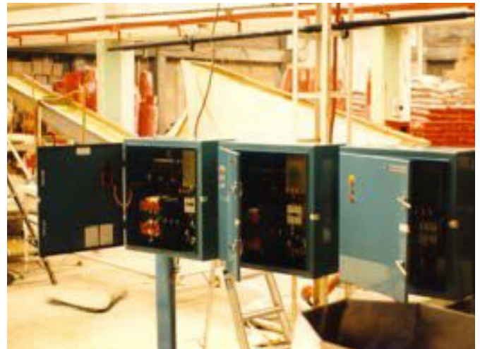
MONTAJE DE ARRANCADORES A TENSIÓN REDUCIDA P/40 H.P. 220 VCA EN BASTIDOR DE FE PTR
