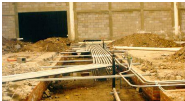
CANALIZACIÓN P/ÁREA DE REFRIGERACIÓN PISO DE VENTAS
