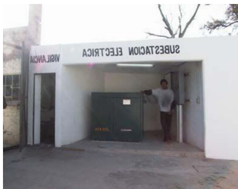
S.E. Tipo Pedestal 225 kVA 23 kV/220-120 VCA
