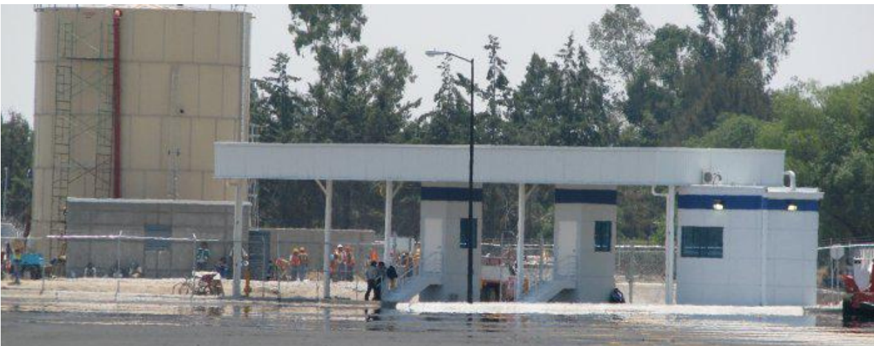
Acceso Norte CDIS Chedraui Teoloyucan y Tanque de Agua
