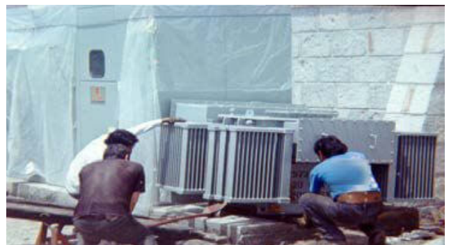
BASE Y MANOBRAS DE MONTAJE
