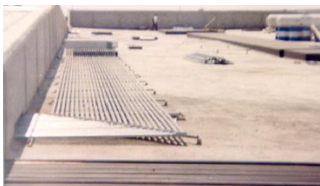
CANALIZACIÓN P/EDIFICIO DE SERVICIOS
