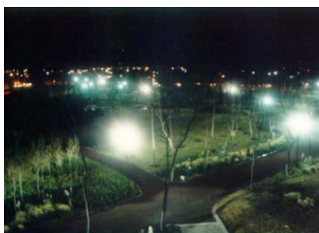
SISTEMA DE ILUMINACIÓN - LUM. PRIMASPHERE 250 W A.M
