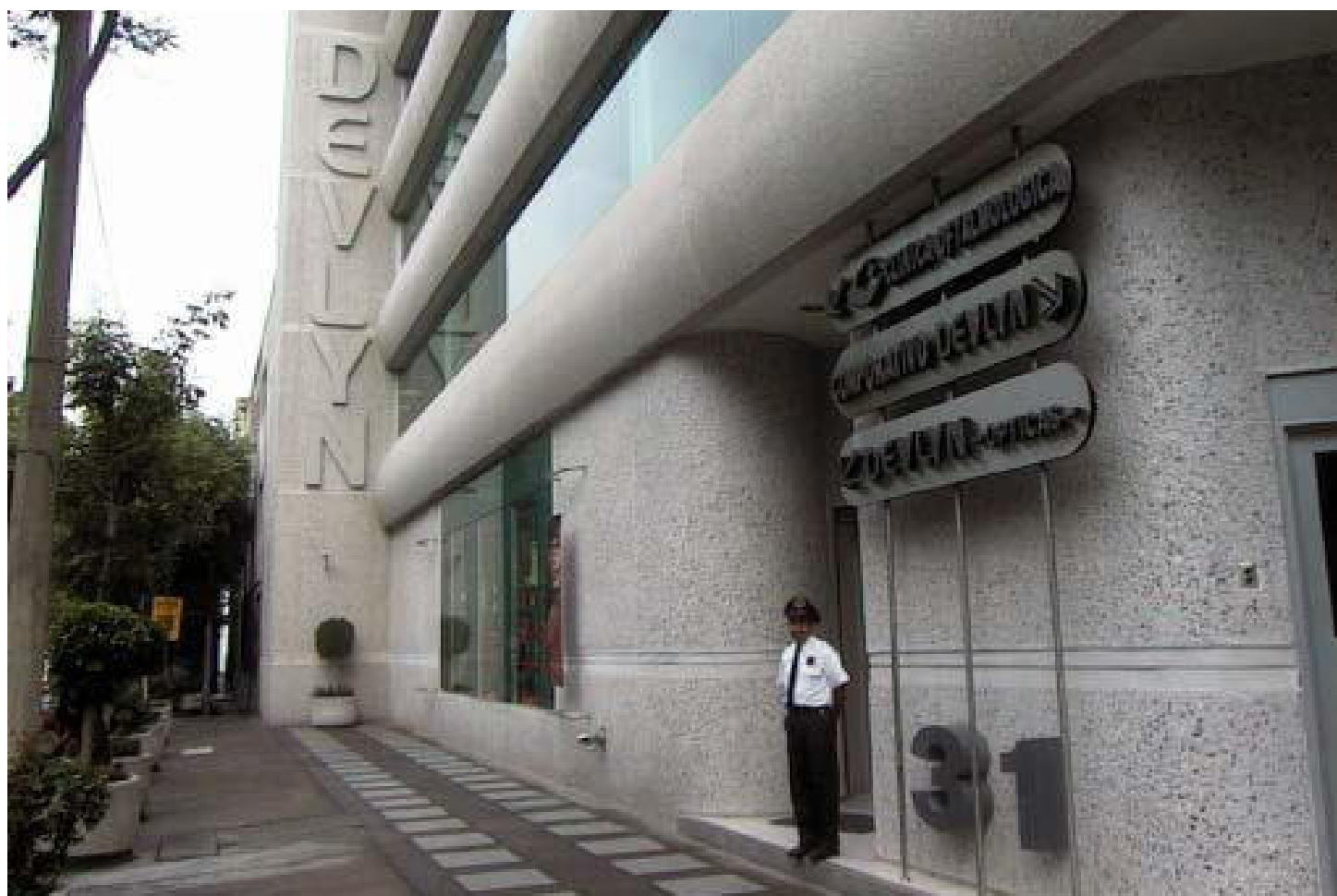
Edificio Corporativo Devlyn
